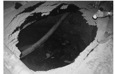
Figura 1 y 2. Subsidiencias producidas a favor de galerías mineras en Ohio. (Fuente: [http://www.dnr.state.oh.us/geosurvey/geo\\_fact](http://www.dnr.state.oh.us/geosurvey/geo_fact), 2006)
